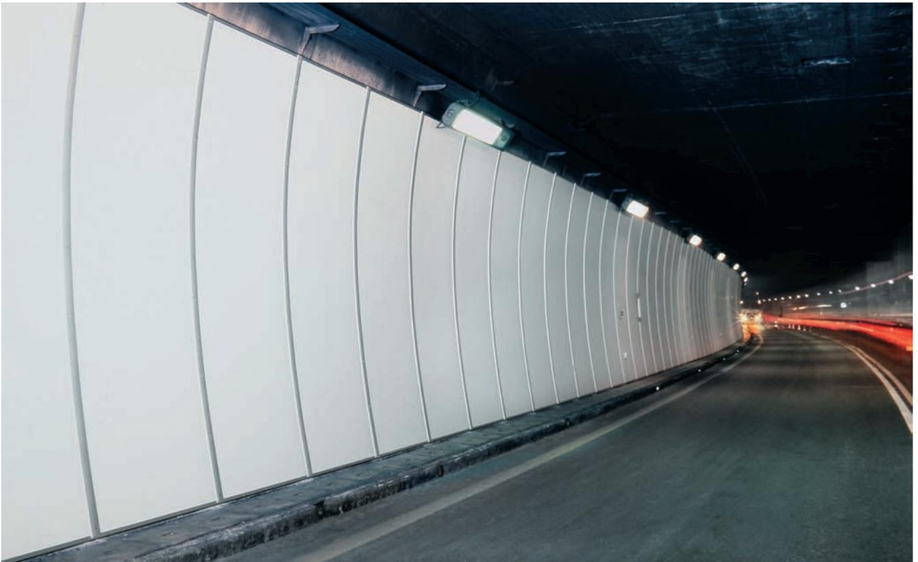
rivestimento secondario deve in questo caso essere costituito da lamiere grecate in acciaio inox a soffitto in grado di convogliare l'acqua dietro il piedritto realizzato con pannelli foto-riflettenti.
