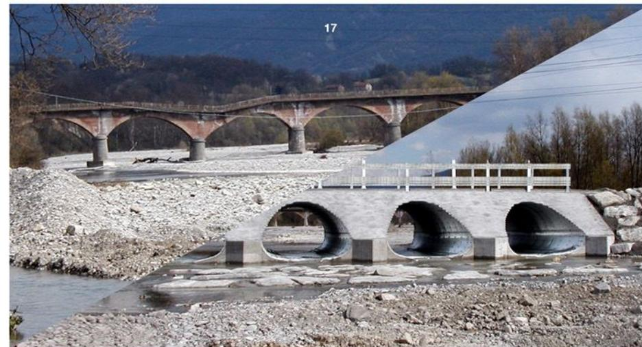
Foto 17 Realizzazione di un guado provvisorio per attraversamento stradale in sostituzione di un vecchio ponte gravemente danneggiato
