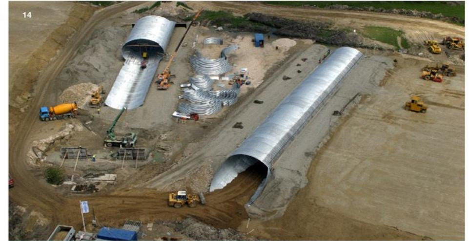
Foto 14 Fase di montaggio e di esecuzione del blocco tecnico. Strutture a grande luce tipo HPE
