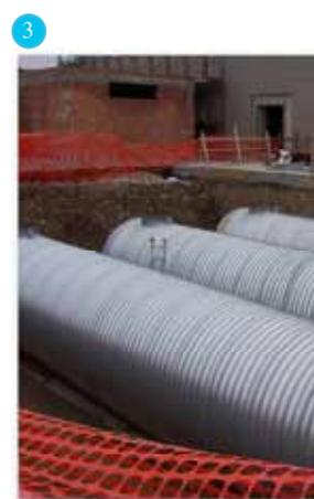
I serbatoi Spirel® sono prodotti con coils in acciaio tipo S250GD zincato a caldo in continuo conforme alla norma UNI EN 10346:2009.
