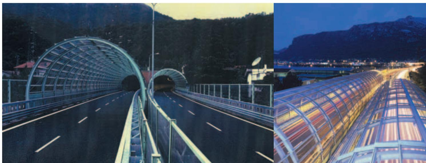
sommava in questo caso il problema dell'evacuazione dei fumi. La soluzione adottata consiste in una struttura ad arco a 3 cerniere a sostegno di lastre in polimetilmetacrilato trasparente.
