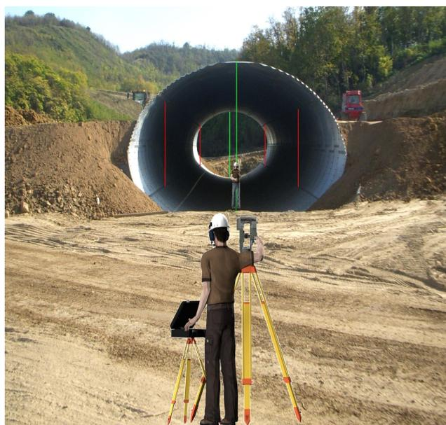
In alternativa si possono utilizzare con personale qualificato strumenti di misurazione topografici.
