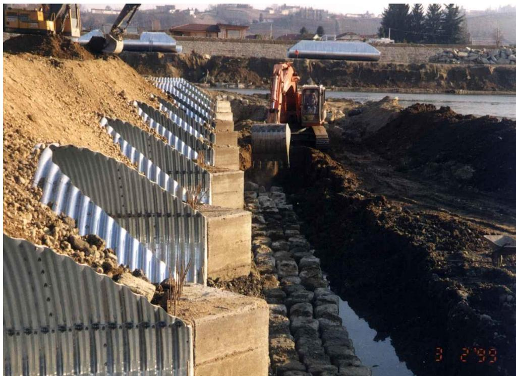
Particolare attenzione va prestata nella posa della condotta in alveo in quanto la posa va effettuata su un letto di posa completamente asciutto realizzato al di sotto del piano dell'alveo.
