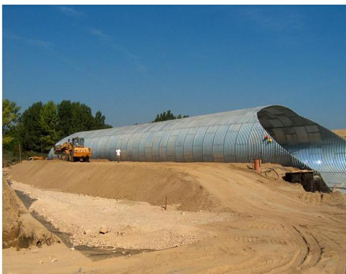
Ove richiesto o precisato dalle specifiche del produttore si dovrà elevare la qualità della compattazione al 90 % della densità massima fornita dalla prova Proctor modificata, secondo EN 13286-2.
