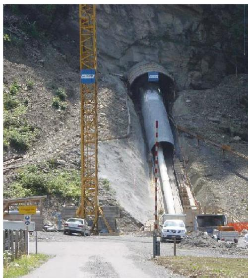
La soluzione che viene utilizzata normalmente si identifica con muri di testa in c.a. e con delle selle di fondazione in c.a., finite con relativo cordolo di coronamento alla condotta o con lame di acciaio.
