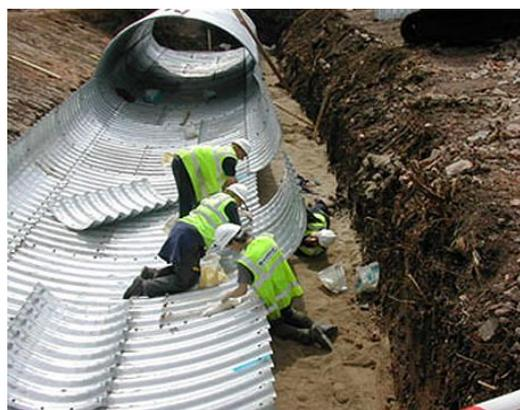
I tempi di installazione possono variare in presenza di condizioni di cantiere non idonee (letto di posa eseguito non correttamente, impossibilità di accedere nella zona di installazione della condotta con il camion con gru).
